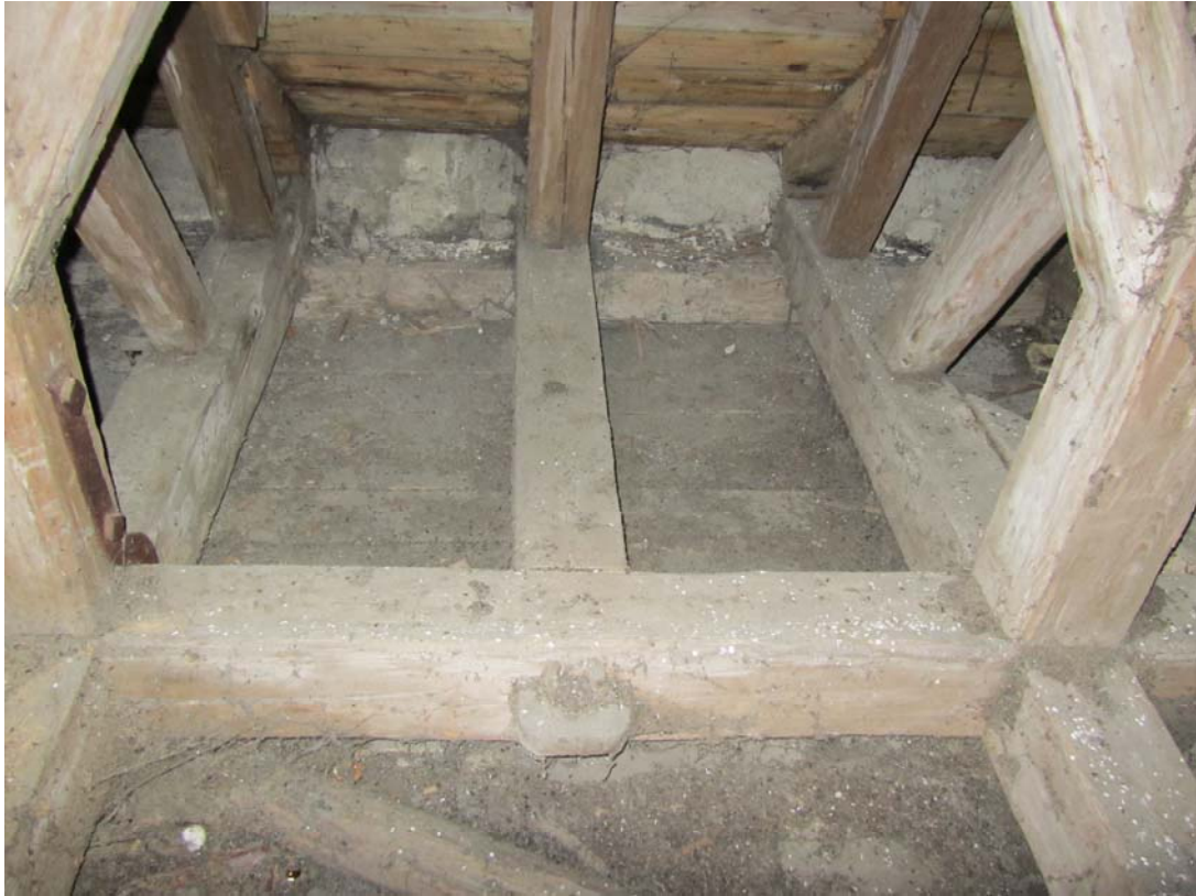
Poutres enchâssées l'une dans l'autre propre en ordre et chevillées.
