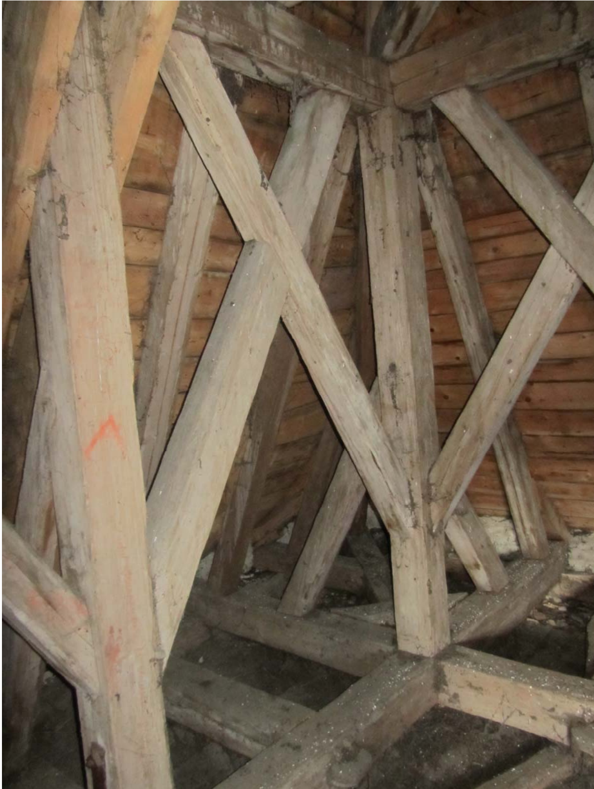
La poutraison du toit de la tour. Celle-ci est probablement elle aussi de 1742. Celle de l'étage supportant les cloches est très imposante.
